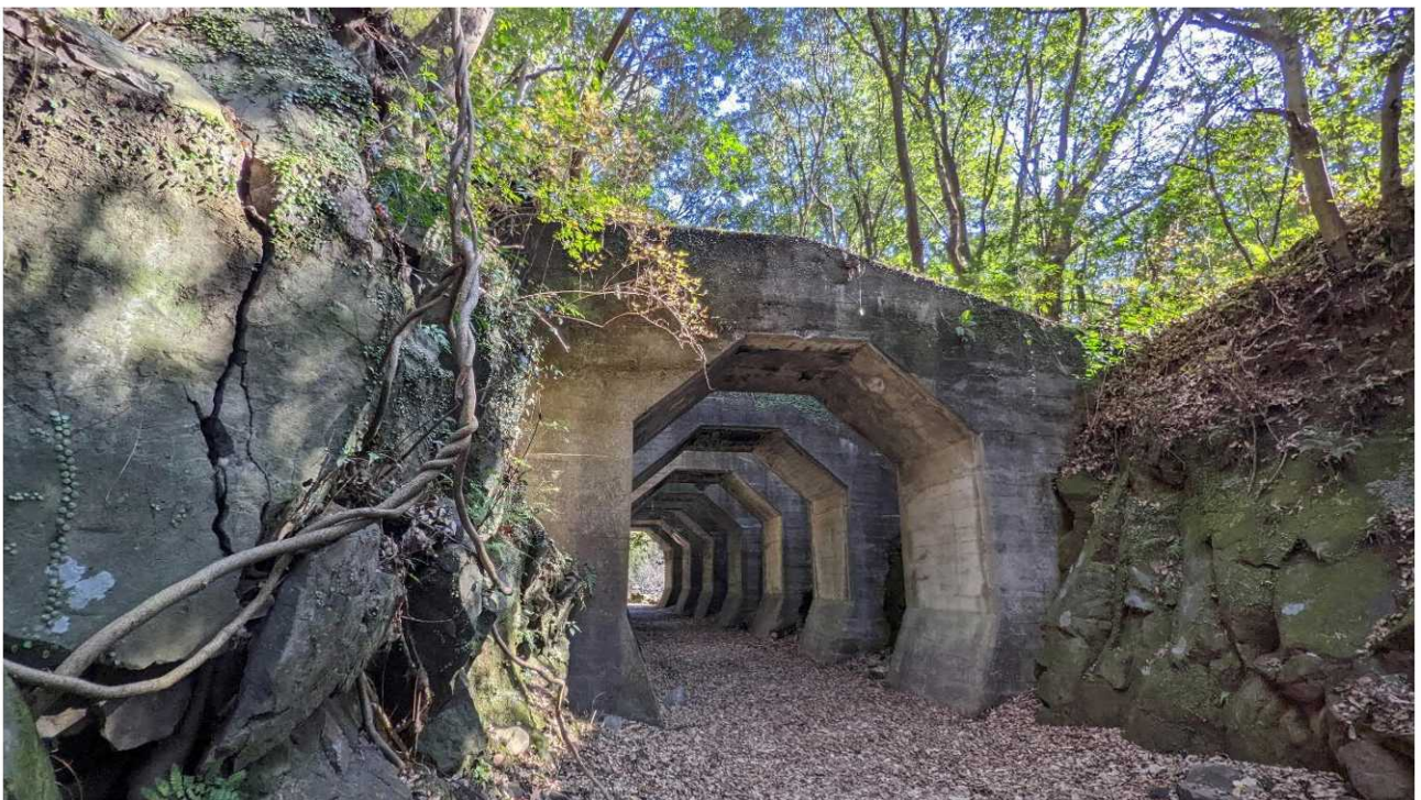
写真3 八角トンネル（熊本県下益城郡美里町） 2021 年出張時に撮影
